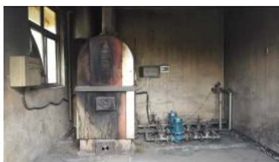
第二小学分校锅炉房内部现状
