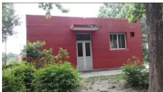
孙村中学换热站外部现状
