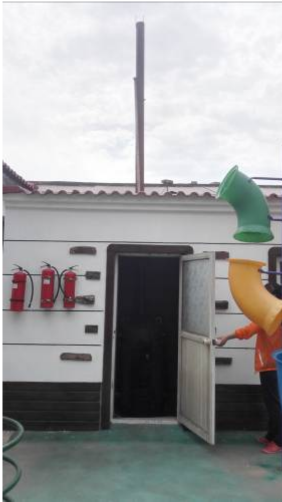
后辛庄分园锅炉房外部现状
