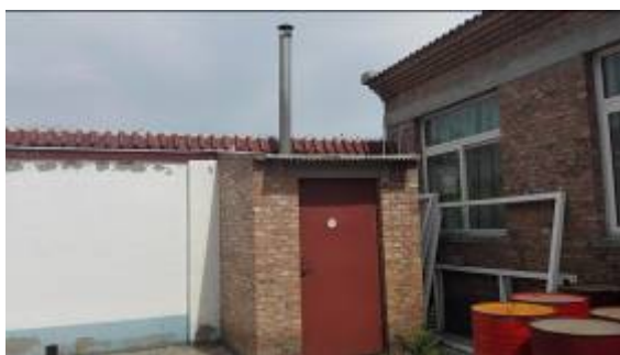
前管营分园锅炉房外部现状
