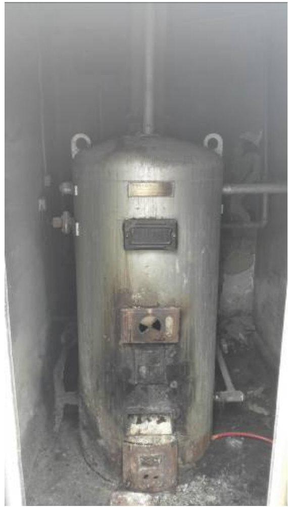
后辛庄分园锅炉房内部现状
